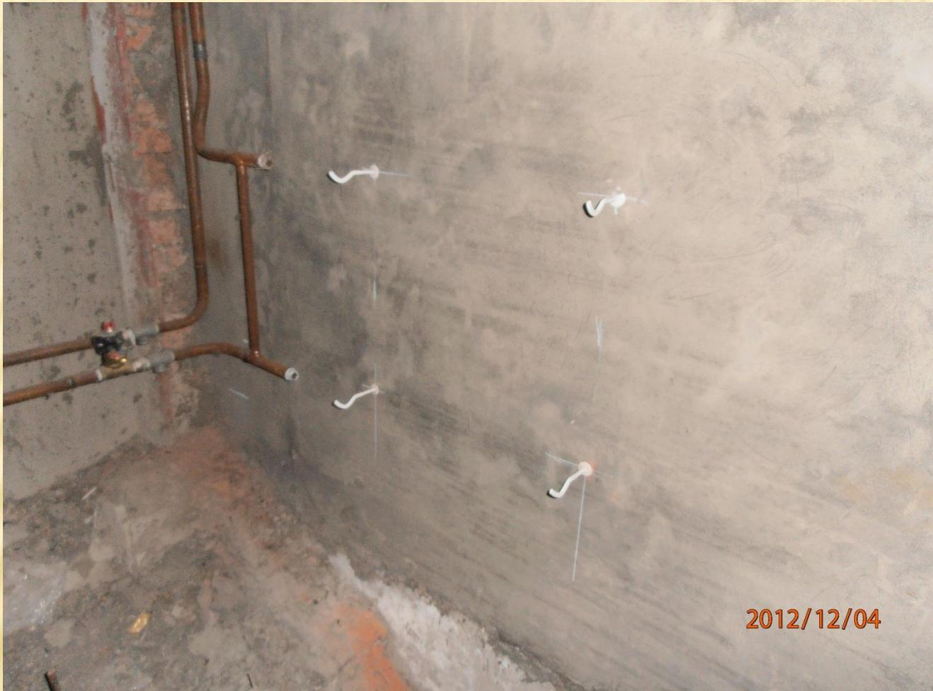
Отсутствуют секции системы отопления (всего отсутствует 272 ранее установленные и оплаченные секции).
