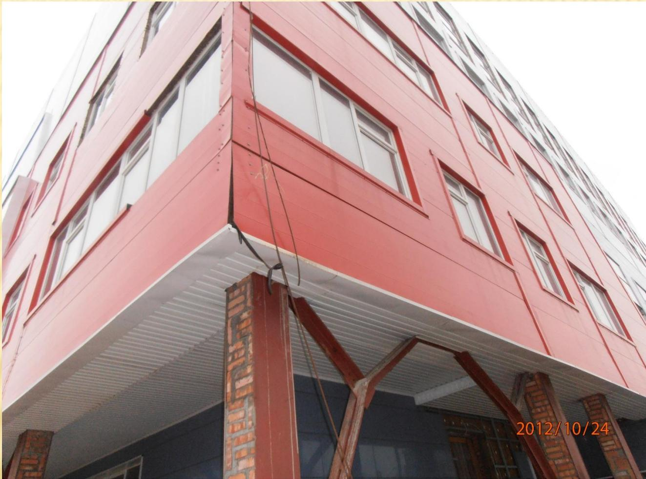
«Флаг». Требуется демонтаж сэндвич-панелей и восстановление крепежной системы данного элемента здания
