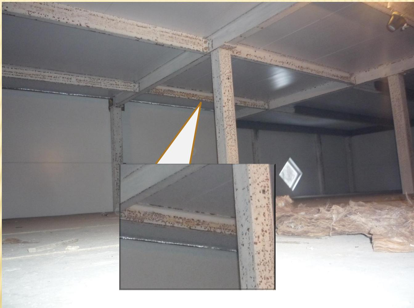
Несущие конструкции административного корпуса (чердачные помещения) имеют следы коррозии, возникшей вследствие нанесения грунтовок в холодное время года. Таким образом, имеет место нарушение технологического процесса.
