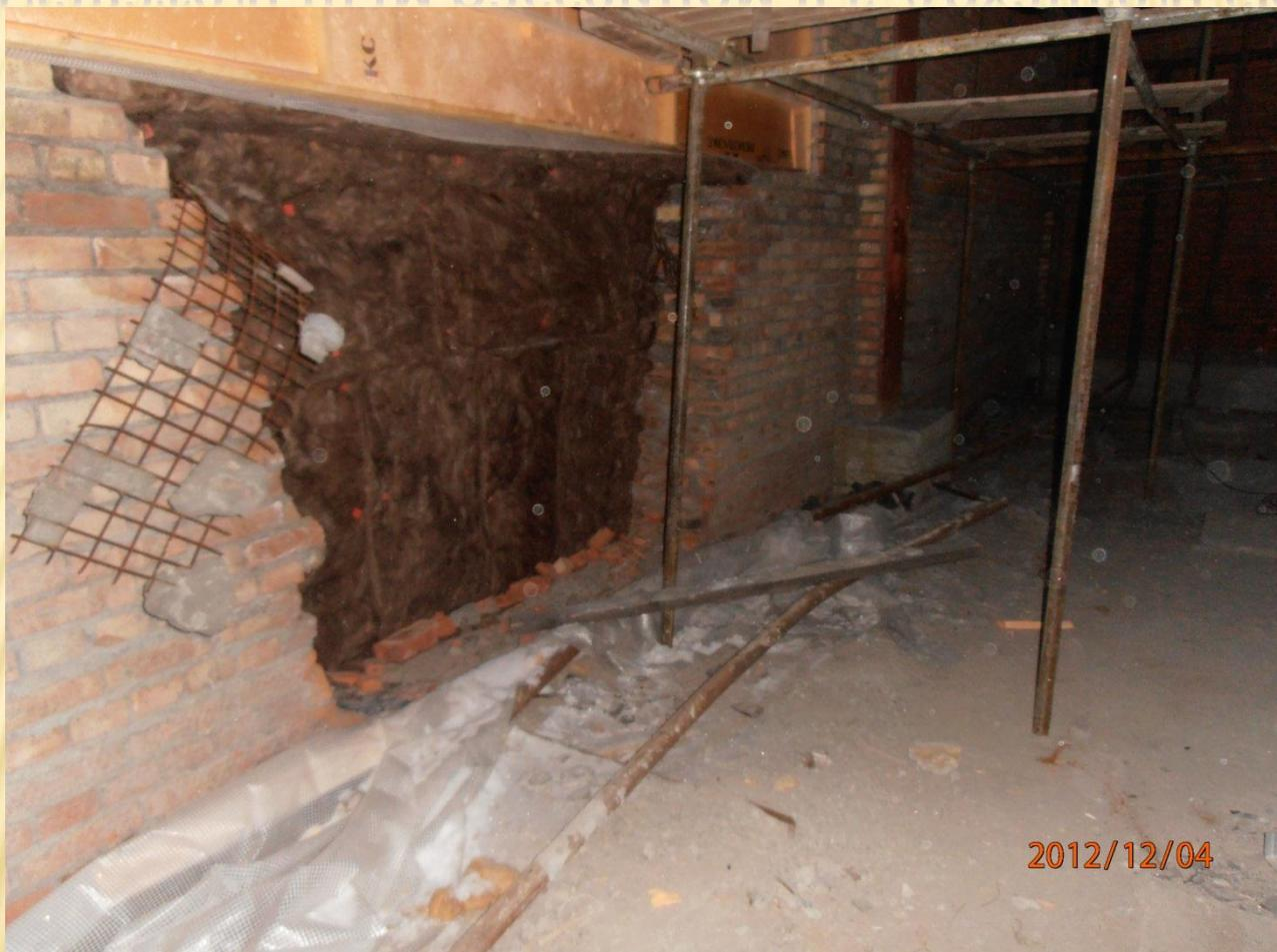
«Технологический проем», созданный для доставки оборудования водоочистки под чашу бассейна.
