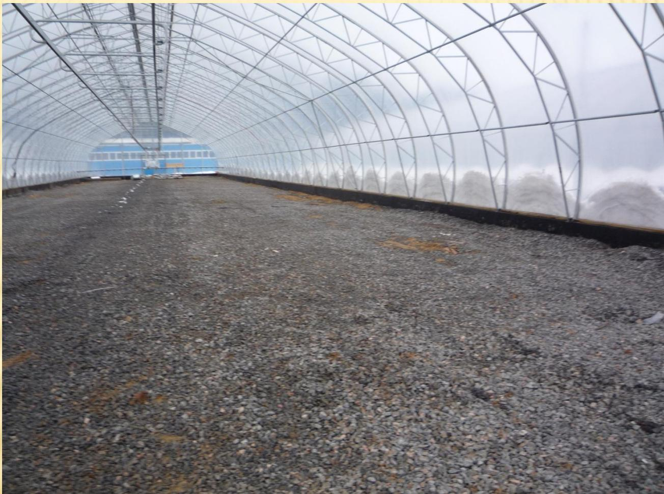
Согласно принятым и оплаченным актам выполненных работ, все теплицы должны иметь отопление, полив, вентиляцию, щебеночное покрытие с поддонами для расположения кассет для сеянцев
